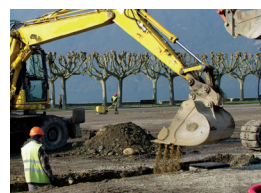
Préparation traditionnelle des fondations
