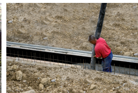
Bétonnage des fouilles après avoir remblayé autour du Fundeco
