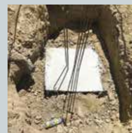
Après coulage du béton
