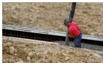
Bétonnage des fouilles après avoir remblayé autour du Fundeco
