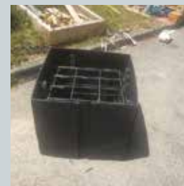
Préparation de coffrage tête de pieux
